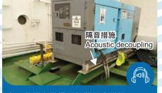
在工程船上的機器加裝隔音措施. 以減低聲音傳送到附近海洋環境
