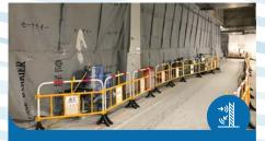
在施工範圍加設可移動隔音屏障以控制 聲浪
