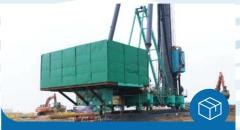
利用隔音罩或隔音棚包圍機動設備以控制 聲浪
