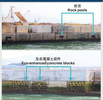
相对於一般的人工海堤组件,生态混凝土组件分散地设置於斜坡式海堤及垂直海堤上,并加入了一系列的独特设计以增加微生境的多样性。生态混凝土组件上有小型的岩池、沟槽及坑纹以增加组件表面的异质性,为潮间带生物提供生境,而岩池则为潮间带及潮下带的可移动生物及附着生物提供庇护空间,使其免受海流和波浪影响。垂直海堤的岩池设有细小的开口,避免吸引雀鸟聚集,从而确保飞机的航行安全。
