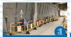
在施工范围加设可移动隔音屏障以控制 声浪
