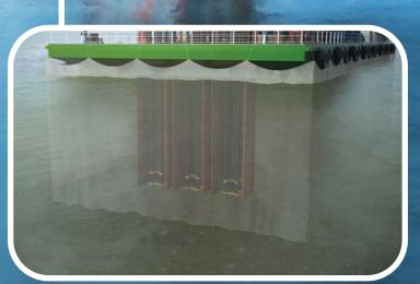
一旦第一道淤泥屏障出現滲漏等緊急情況,會即時放下第二道淤泥屏障,圍封整艘工程船及其工程範圍,避免淤泥擴散至附近海域。
