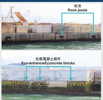
相對於一般的人工海堤組件,生態混凝土組件分散地 設置於斜坡式海堤及垂直海堤上,並加入了一系列的 獨特設計以增加微生境的多樣性。生態混凝土組件上有 小型的岩池、溝槽及坑紋以增加組件表面的異質性,為 潮間帶生物提供生境,而岩池則為潮間帶及潮下帶的 可移動生物及附著生物提供庇護空間,使其免受海流和 波浪影響。垂直海堤的岩池設有細小的開口,避免吸引 雀鳥聚集,從而確保飛機的航行安全。
