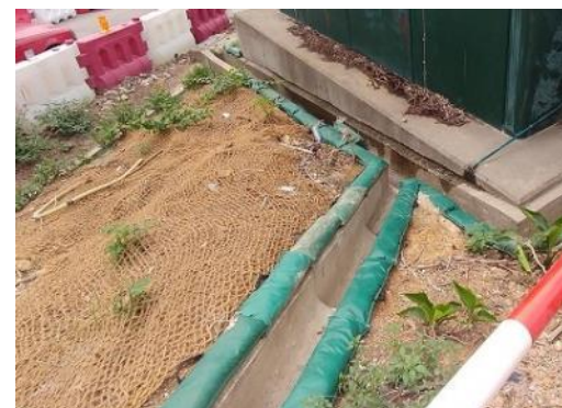
铺设沙包以防渠道淤塞
