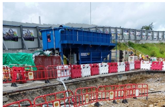
检查污水处理设施
