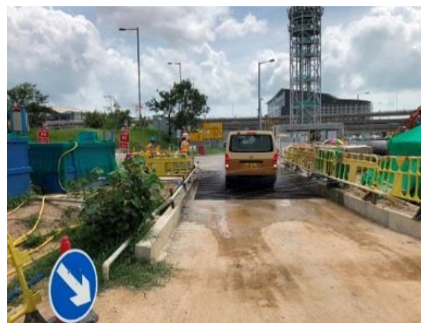
车辆离开工程范围前须经 高压喷射冲洗
