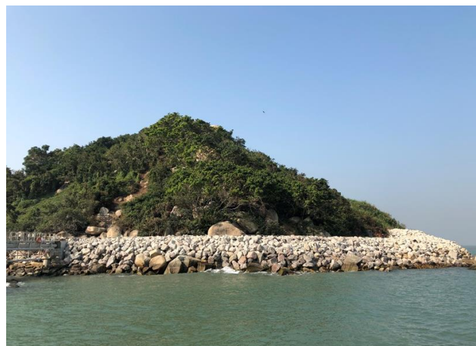
上沙洲海岸线的修复工程采用了重用填料
