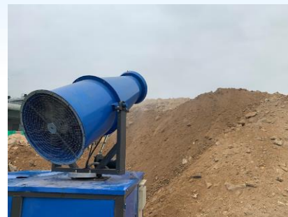
塵埃抑制措施：安裝自動噴霧器及灑水器
