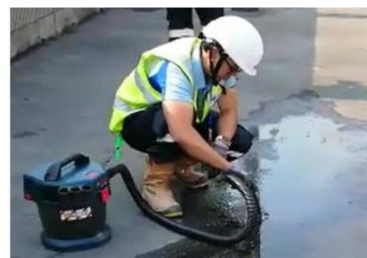
污水水質：使用專用吸塵器
