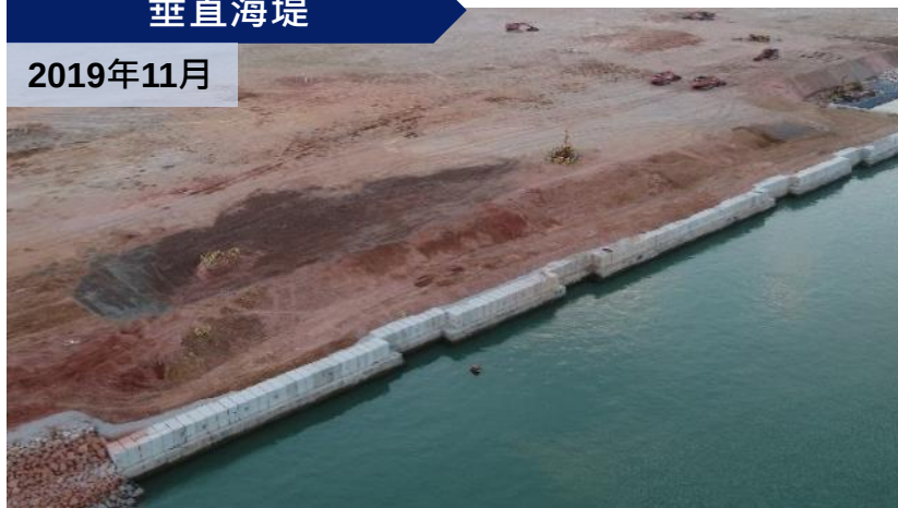
填料鋪設工程
