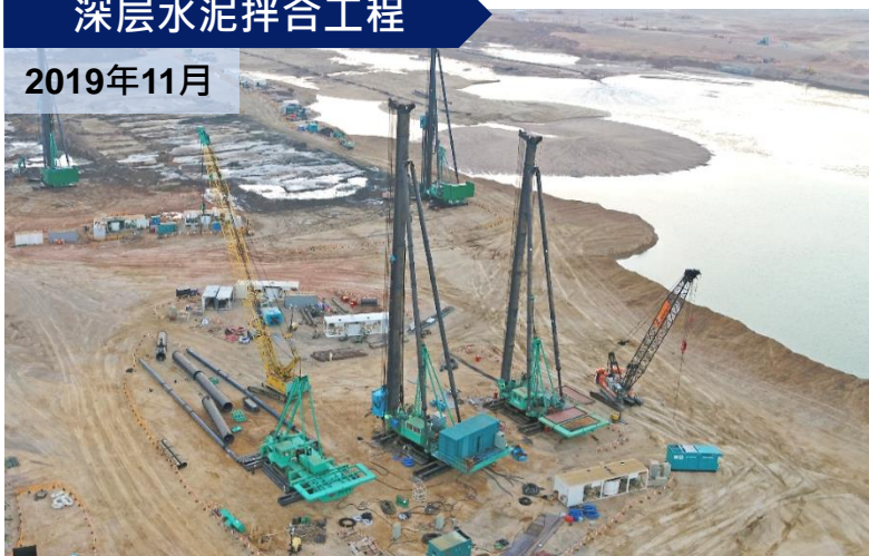
深层水泥拌合工程
