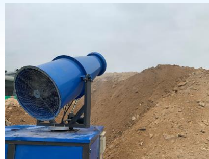
尘埃抑制措施：安装自动喷雾器及洒水器
