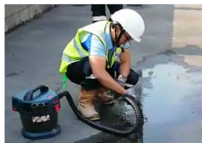
污水水质：使用专用吸尘器
