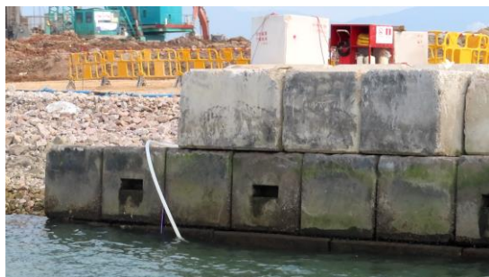
2020年初完成安装26组岩池
