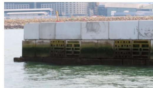
2020年初完成安装116组生态混凝土组件
