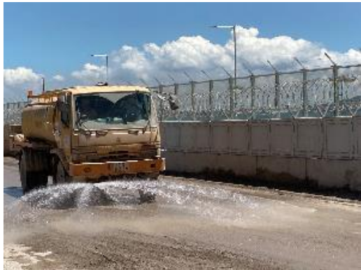
在工地主要运输路线 定时洒水 减少尘土飞扬
