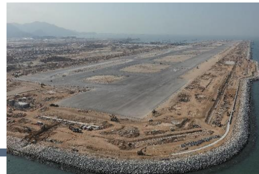
第三跑道路面工程 于2021年7月竣工
