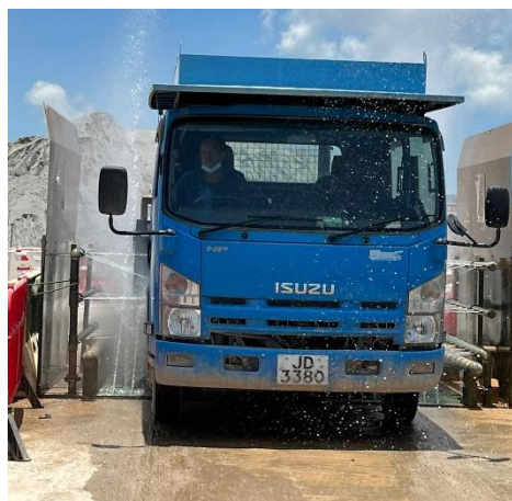
在工地出口安装 高压水自动车轮清洗设施 为车辆的轮胎除去尘埃
