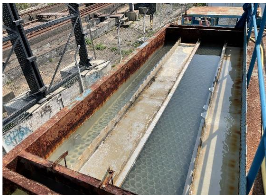
地盘污水必须在工地内的 污水处理设施 处理后才能排放
