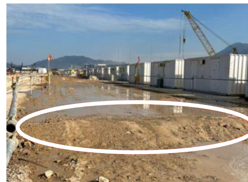
在工地主要运输设置土堤作为 速度缓冲垫 以降低车辆速度并减少尘土飞扬
