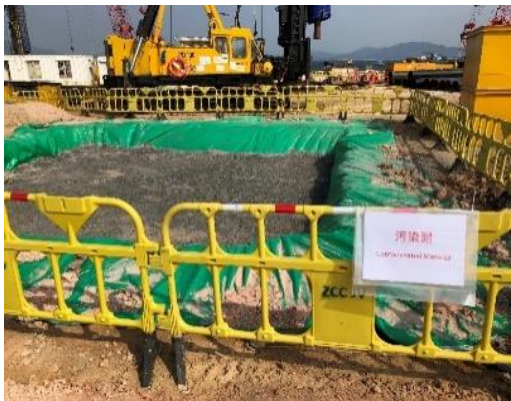
暂存回填海泥时使用 不渗透布 以防止海泥污染物渗漏到周边环境
