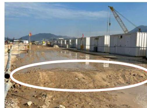
在工地主要運輸設置土堤作為**速度緩衝墊**以降低車輛速度並減少塵土飛揚
