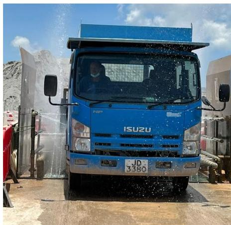
在工地出口安裝**高水壓自動車輪清洗設施**為車輛的輪胎除去塵埃
