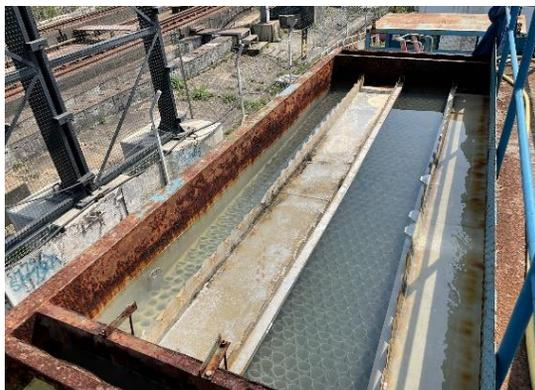
地盤污水必須在工地內的**污水處理設施**處理後才能排放
