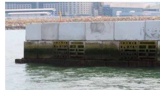
2020年初完成安裝116組生態混凝土組件
