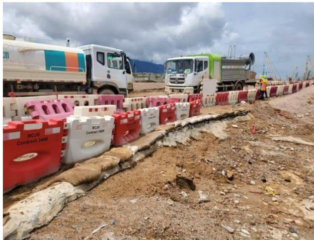
在水马下方放置沙包以防止泥水流出工地范围以外
