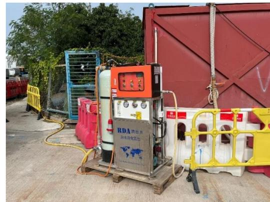
利用海水淡化装置，用淡化的水来喷洒地面，防止尘土飞扬
