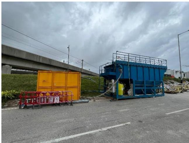
在污水处理设施旁设置大容量的沉淀缸以提高处理污水效能
