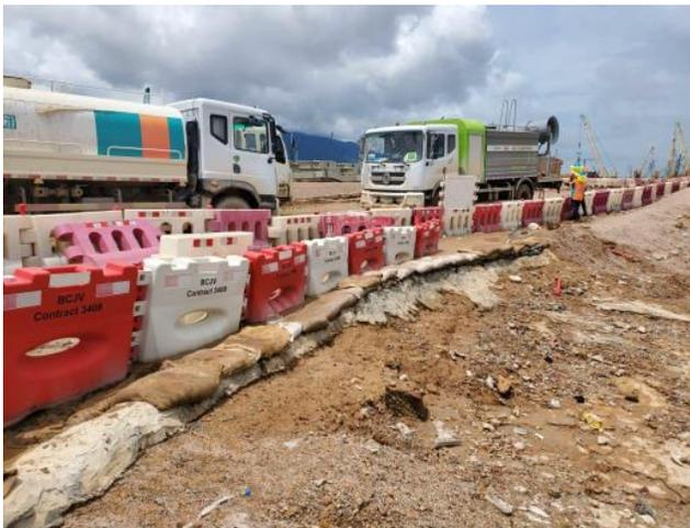
在水馬下方放置沙包以防止泥水流出工地範圍以外
