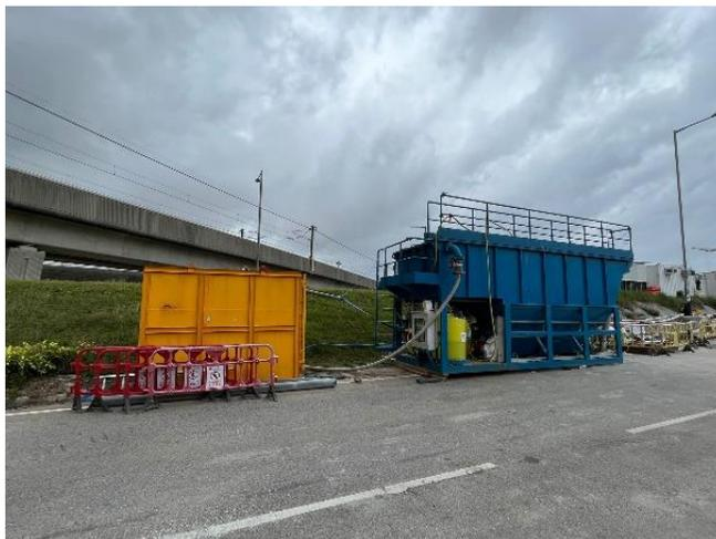
在污水處理設施旁設置大容量的沉澱缸以提高處理污水效能
