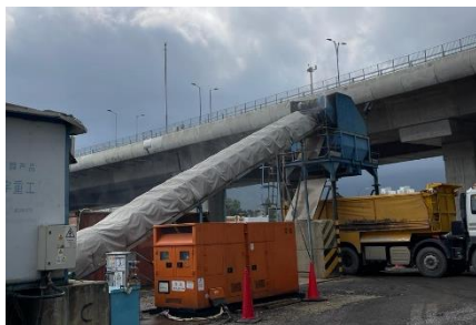
围蔽运送物料输送带顶部及两边，以防止尘土飞扬
