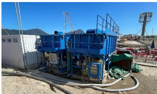
在污水处理设施旁设置大容量沉淀缸以提高处理污水效能
