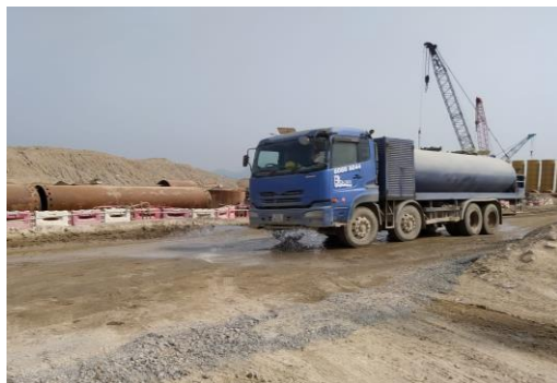
定时在工地主要运输道路洒水防止尘土飞扬
