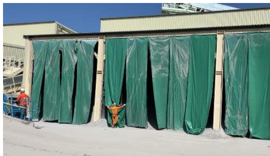
在物料储存区装设门帘防止尘土飞扬
