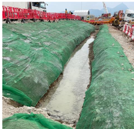
在地盘范围周边设立截流排水沟, 防止污水流出地盘范围
