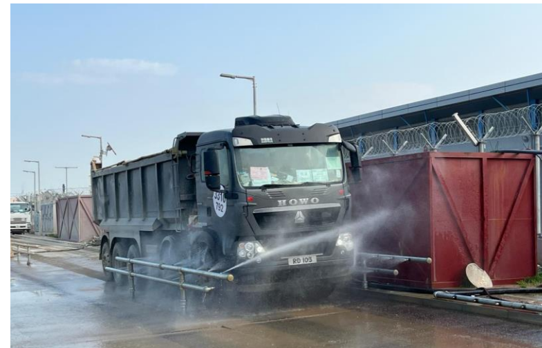
在工地出口设置双重自动洗车设施以提高成效
