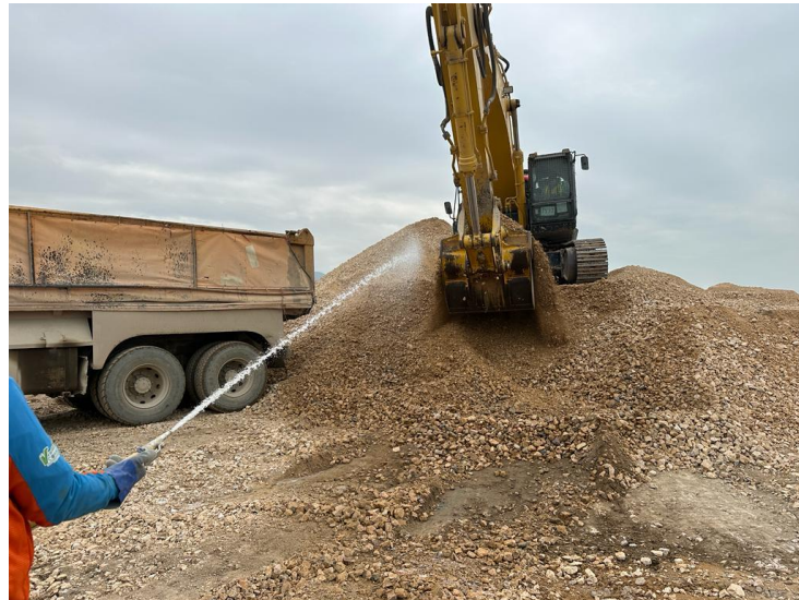
定时在物料储存区洒水，减少尘土飞扬
