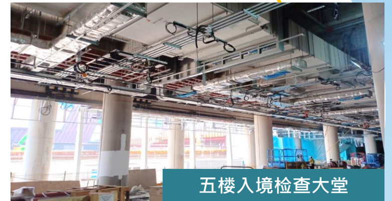
扩建后的二号客运大楼 装修及屋宇设备工程
