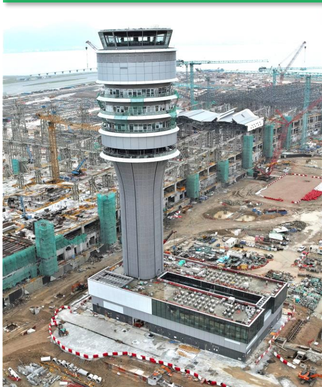
新航空交通管制指挥塔
