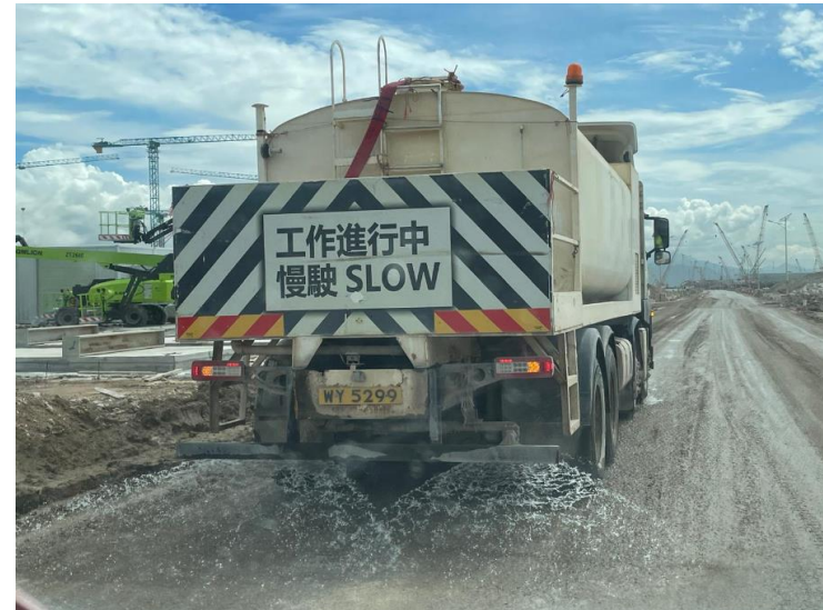
定时在工地主要运输路线洒水，减少尘土飞扬
