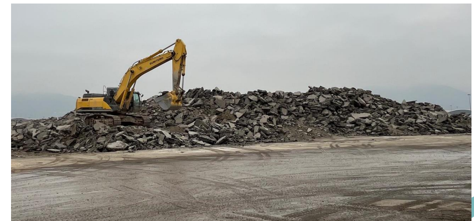
中跑道改建工程所产生的沥青，于三跑工地上循环再用
