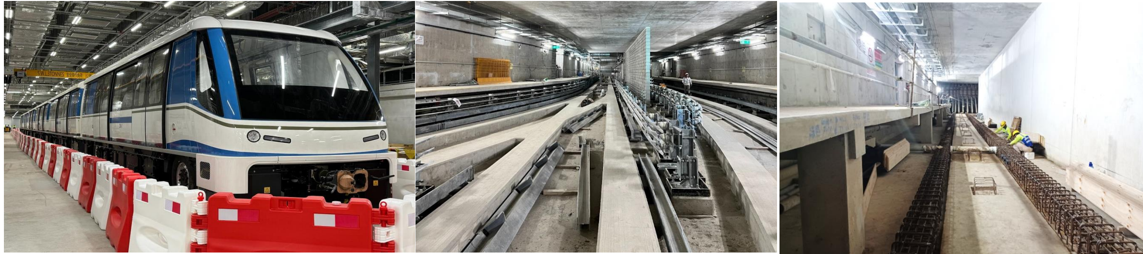
付运首两趟旅客捷运系统列车至旅客捷运系统车厂，以及于旅客捷运系统隧道内进行建造工程
