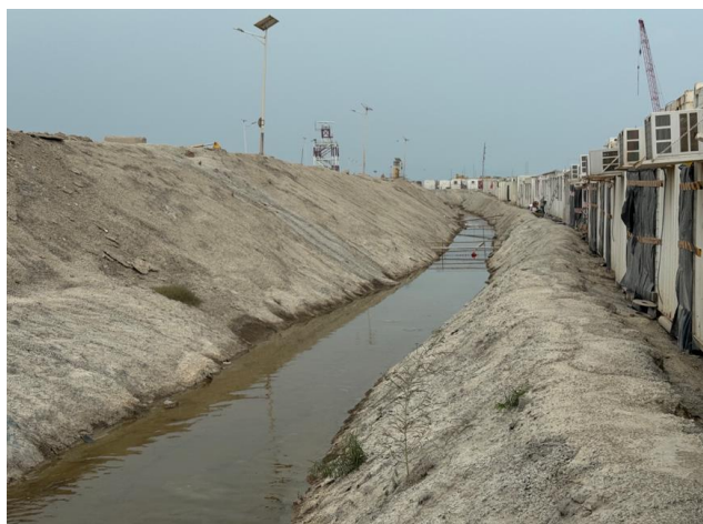
在地盘范围周边排水沟设置堤坝，防止污水流出工地外
