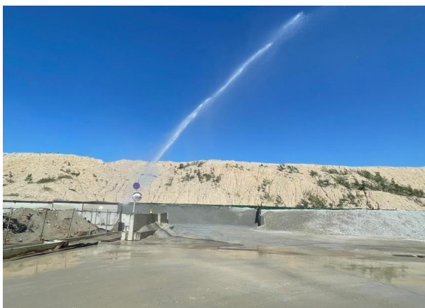
安裝自動灑水器，定時向物料儲存區灑水
