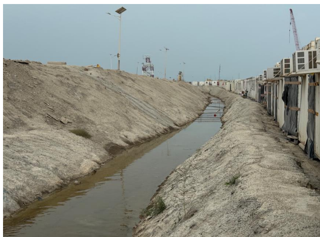
在地盤範圍周邊排水溝設置堤壩，防止污水流出工地外
