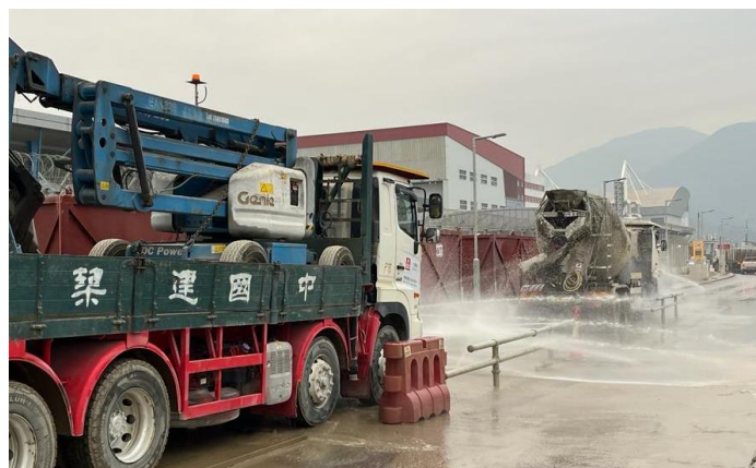
在工地出口設置雙重自動洗車設施以提高成效
