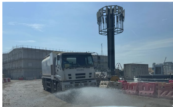
定時在工地及主要運輸路線灑水，防止塵土飛揚
