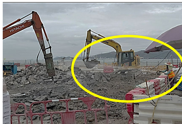
在進行打鑿工序時進行灑水，減少塵土飛揚
