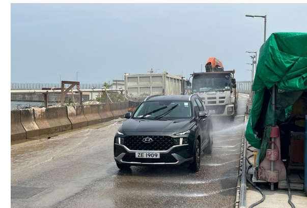
在工地出口設置自動強力灑水洗車設施
