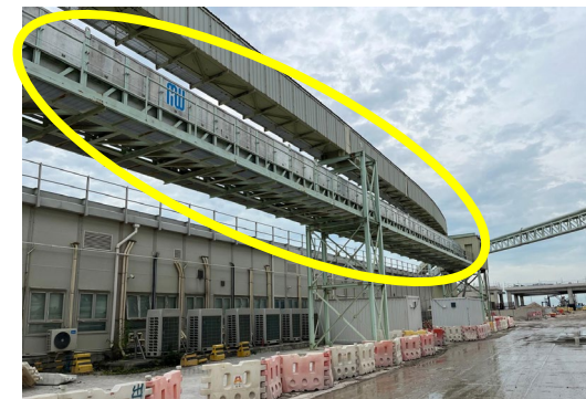
使用全密封式輸送帶運送易生塵埃物料，防止塵土飛揚
