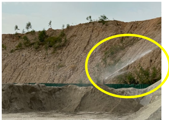
安裝自動灑水器定時向物料儲存區灑水，減少塵土飛揚
