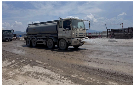
定時在工地及主要運輸路線灑水，防止塵土飛揚
