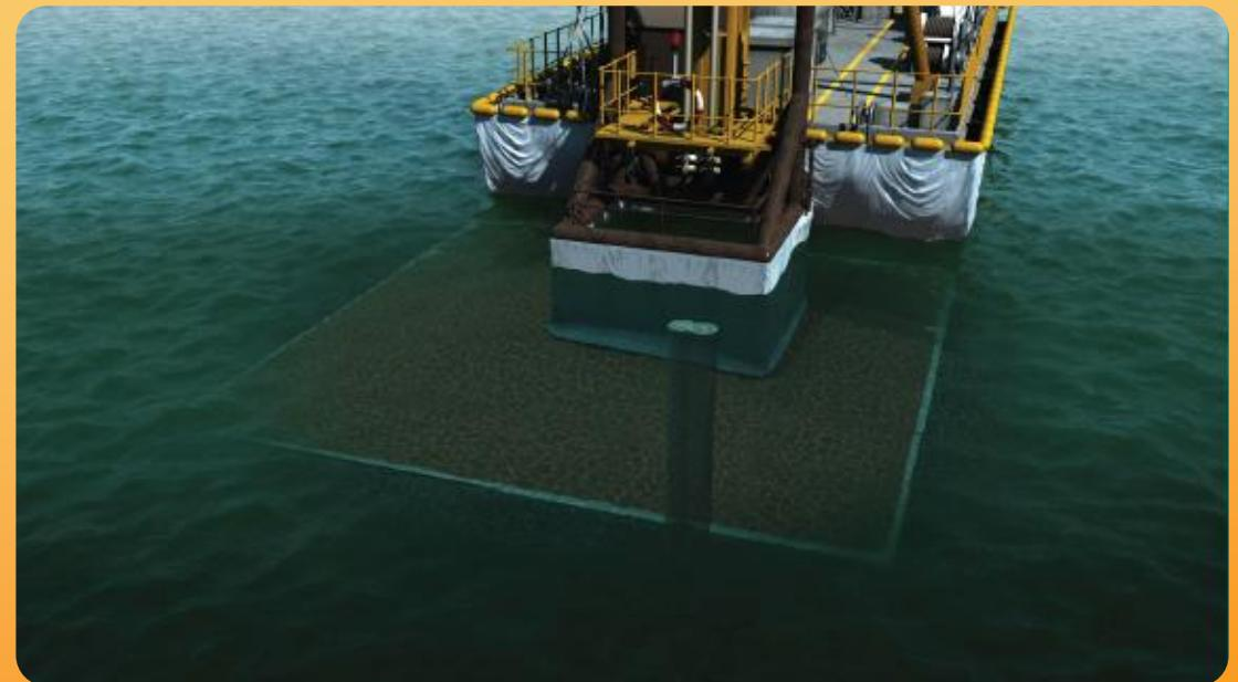
4. 凝固后坚硬的水泥柱成为填海工程的地基
