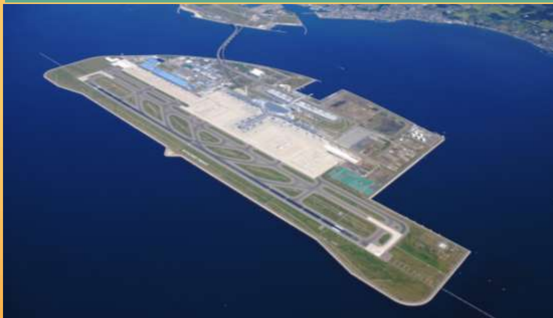
日本名古屋中部國際機場部分填海工程
