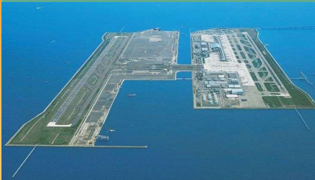
日本關西機場第二期部分填海工程
