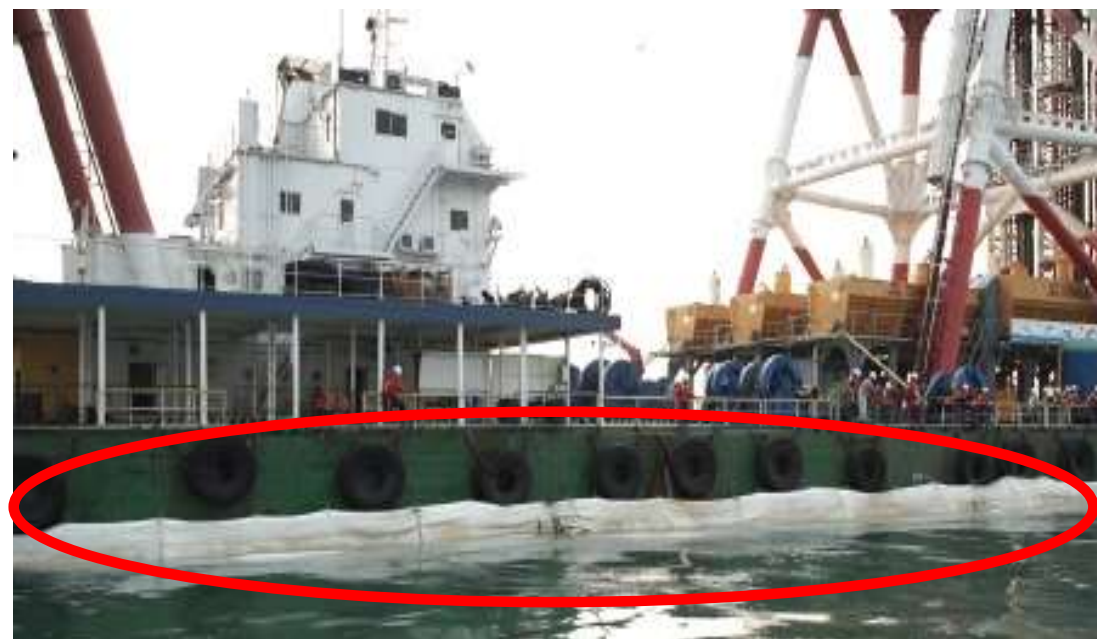
2. 在深层水泥拌合作业趸船/工程范围四周设置淤泥屏障，以应付紧急事故
