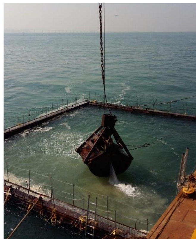
铺设砂垫层的淤泥屏障
