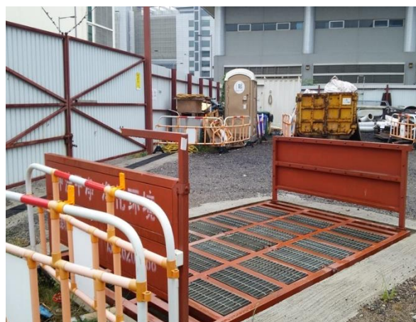
地盤出口洗車池
