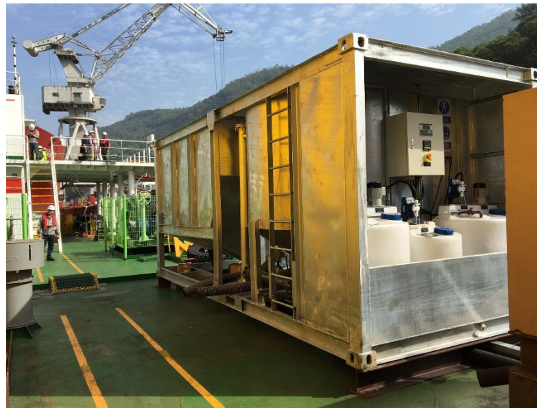
躉船上的工程相關污水儲存缸
