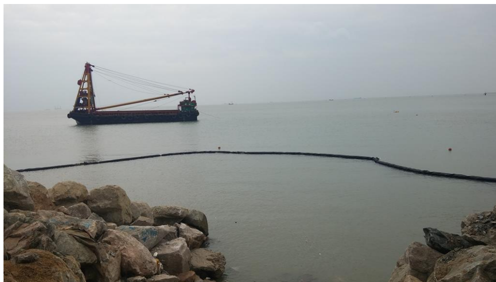
設置淤泥屏障
