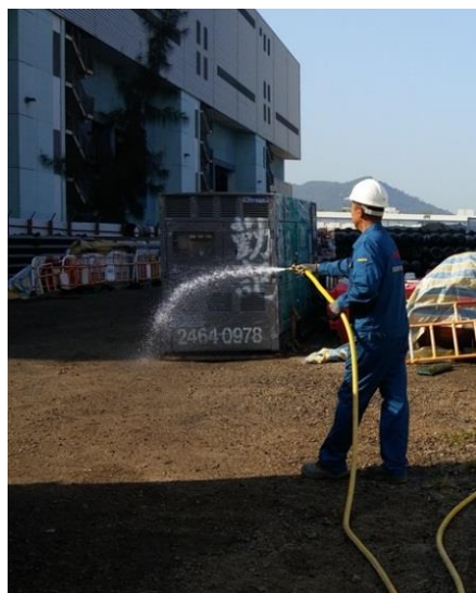
在未鋪設的地面灑水，改善塵埃飛揚情況
