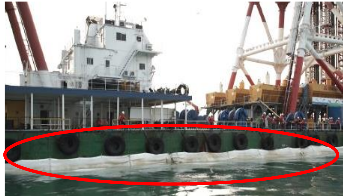
2. 在深層水泥拌合作業躉船/工程範圍四周設置淤泥屏障，以應付緊急事故
