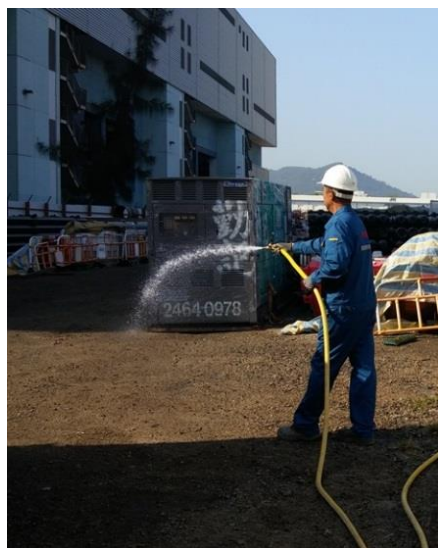
在未铺设的地面洒水，改善尘埃飞扬情况
