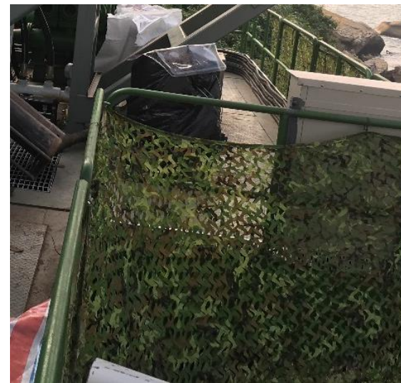
已伪装外围的工程设备
