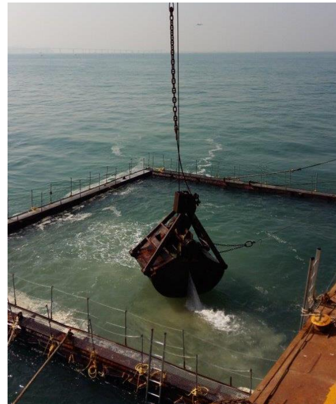
铺设砂垫层的淤泥屏障
