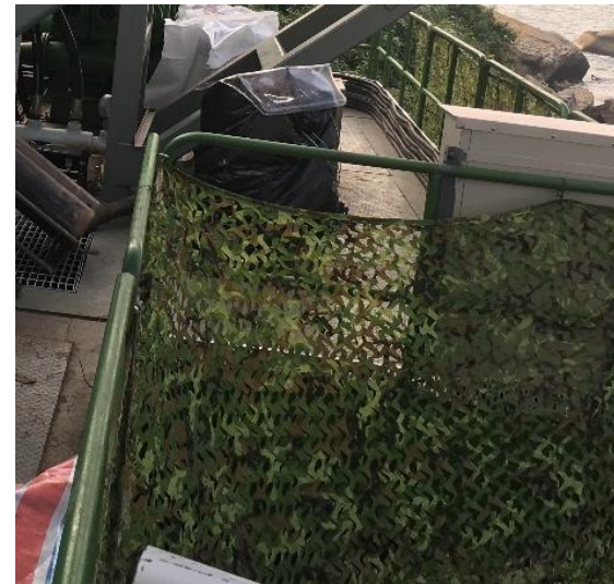
已偽裝外圍的工程設備
