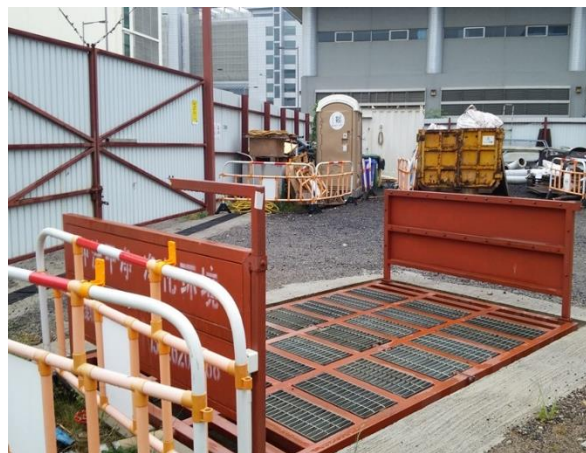
地盤出口洗車池
