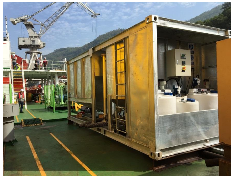
躉船上的工程相關污水儲存缸
