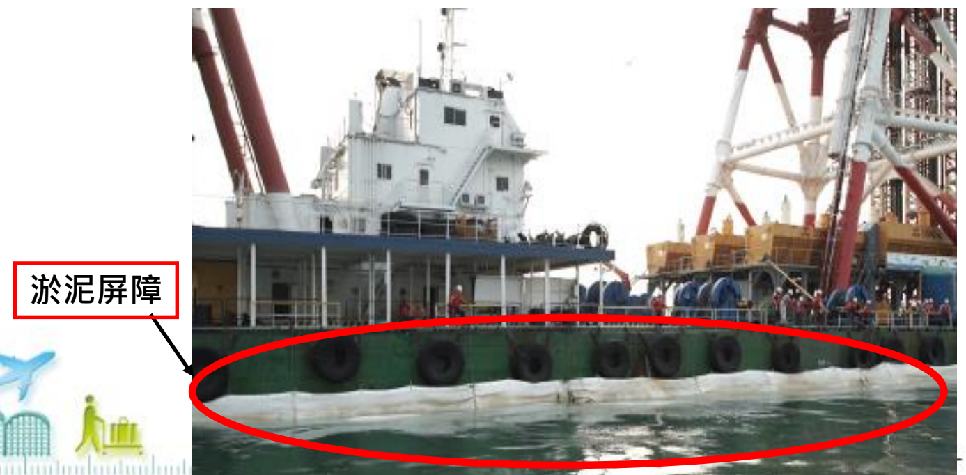
2. 深層水泥拌合工程船 / 工程範圍周圍設置淤泥屏障，作為第二層保護
