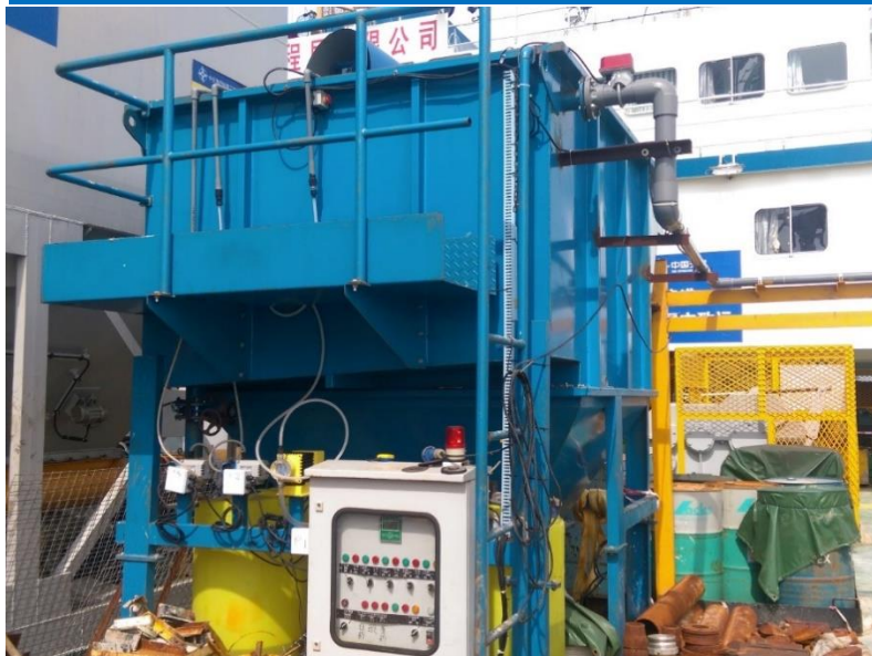
安裝污水處理系統
