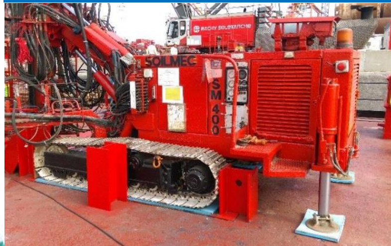
使用隔音墊減低水底噪音 對海洋生物的影響
