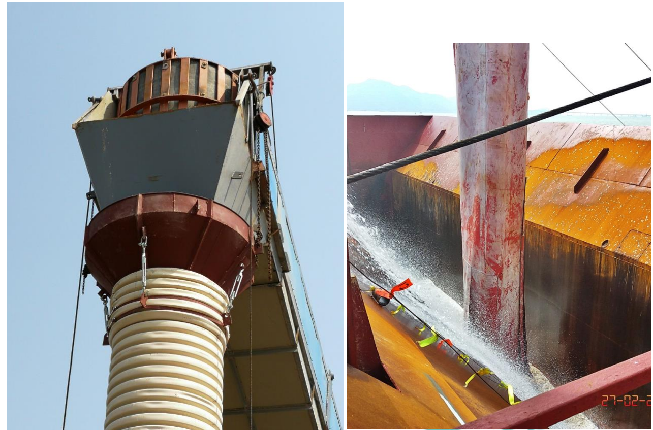
由Pelican Barge至籠式淤泥屏障完全密封
