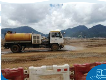
水车定期在工地的主要运输路线上洒水 Water bowzers spray and dampen the main haul road regularly
