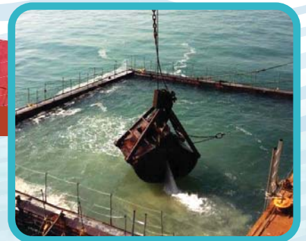
在淤泥屏障内铺设砂垫层 Laying of sand blanket inside silt curtain
