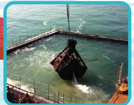
在淤泥屏障內鋪設砂墊層 Laying of sand blanket inside silt curtain
