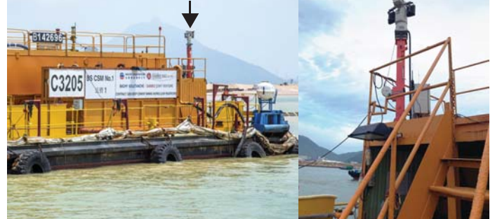
在工程船上安裝的閉路電視監察系統 CCTV installed on work barge
