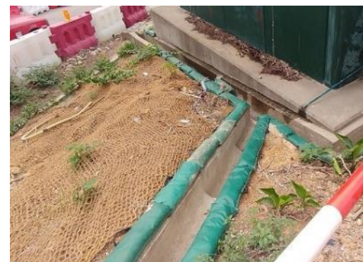
鋪設沙包以防渠道淤塞
