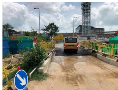
車輛離開工程範圍前須經 高壓噴射沖洗
