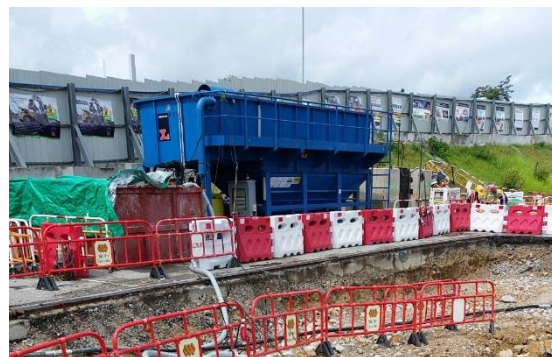
檢查污水處理 設施
