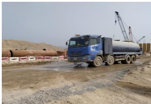
定時在工地主要運輸道路灑水防止塵土飛揚
