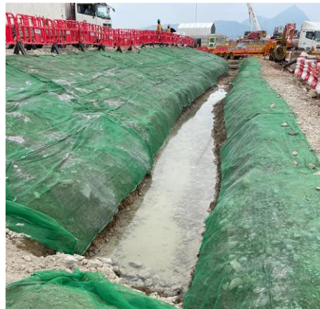
在地盤範圍周邊設立截流排水溝, 防止污水流出地盤範圍
