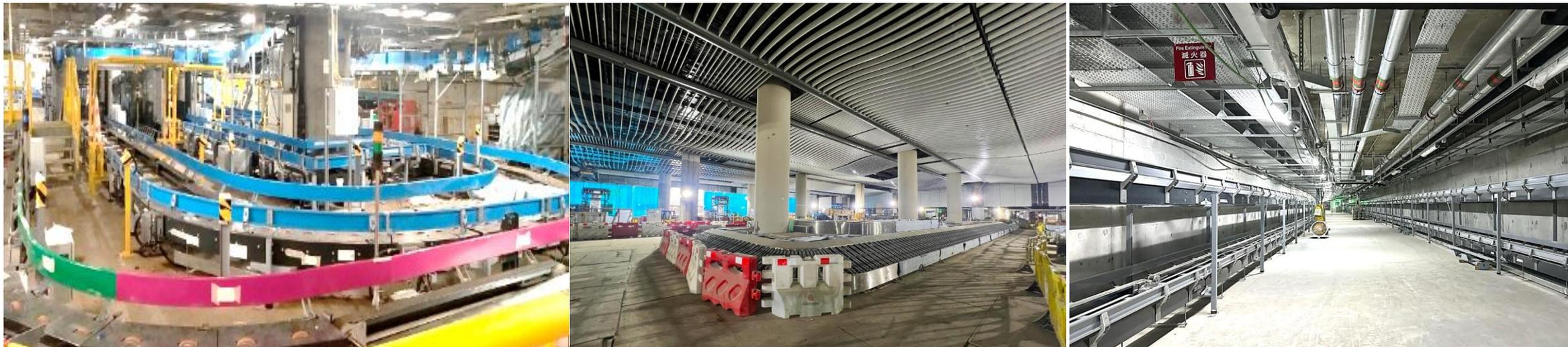
於一號客運大樓、二號客運大樓及行李處理系統隧道內進行行李處理系統安裝工程
