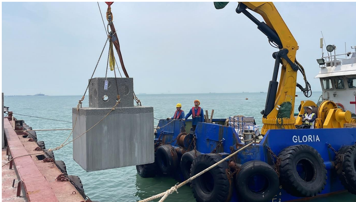
於2025年5月完成敷設500座人工魚礁
