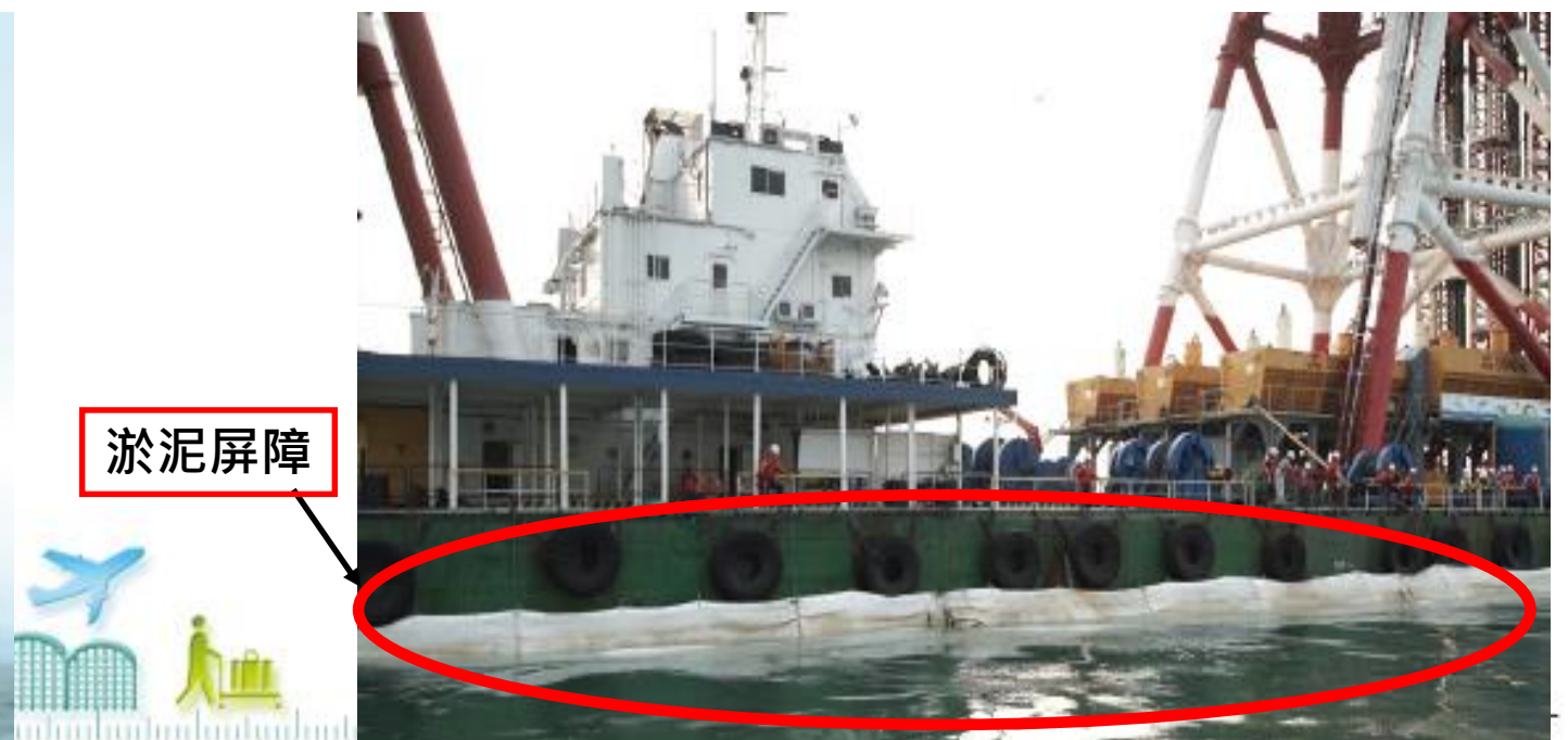
2. 深層水泥拌合工程船 / 工程範圍周圍設置淤泥屏障，作為第二層保護
