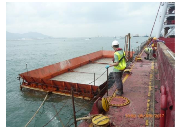
工程時設置淤泥屏障，減低對附近環境的影響
