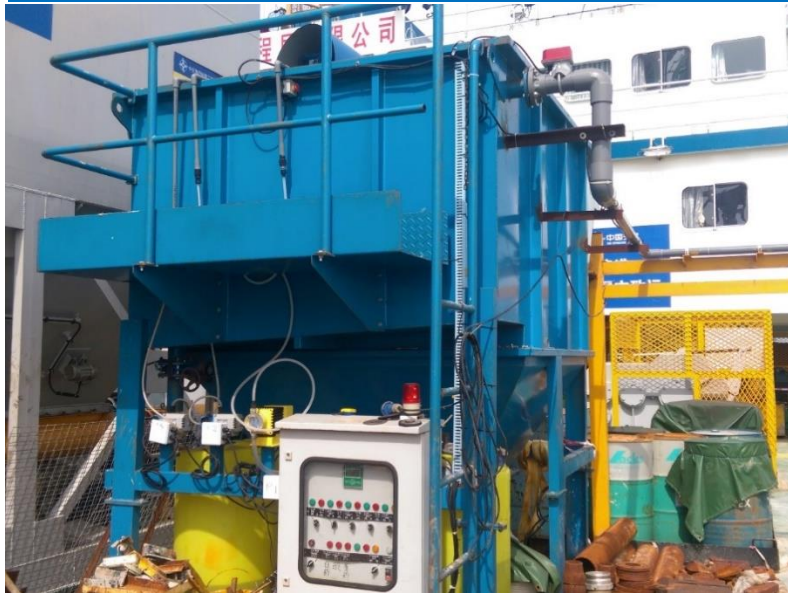
安裝污水處理系統
